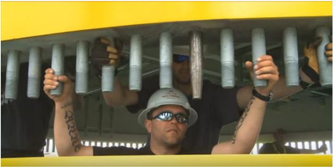
Figure 3-2 Current use of guide pins (SCHEUERLE Fahrzeugfabrik, 2012)
