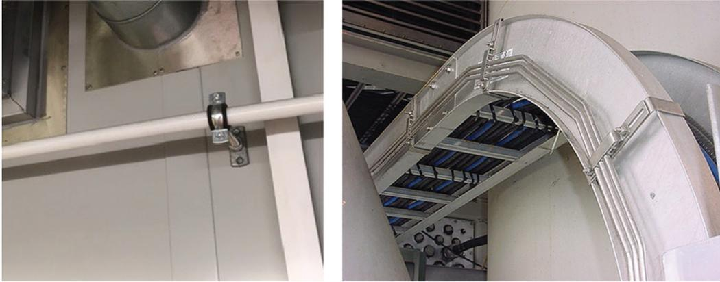
圖25：應使用適當的工程管夾
