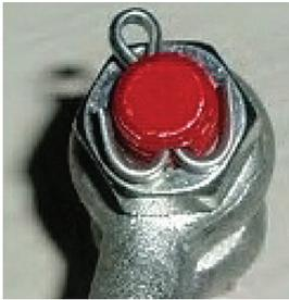
圖11：確保銷釘正確展開，以降低鉤掛和受傷的風險
