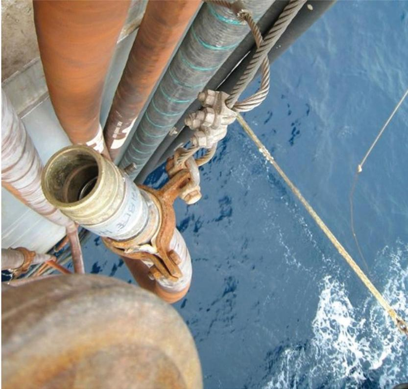
圖9：夾具選擇不佳的自製吊裝裝置（來源：DROPS）
