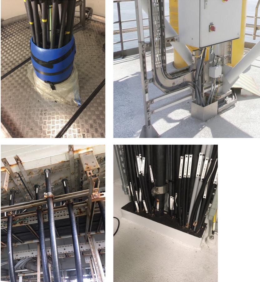
圖24：所有管道和設備導孔都應配備周邊擋板，覆蓋面積應盡可能大
